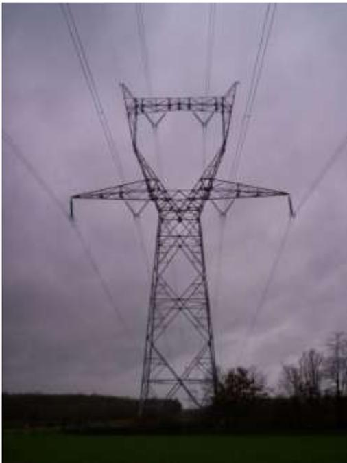
Le triphasé coûte moins cher au transport : 3 fils suffisent pour transporter la puissance  $P = 3 U I \cos\phi$  (voir plus loin dans le cours), alors qu'il en faut 2 en monophasé pour transporter  $P = U I \cos\phi$  d'où une économie appréciable sur le cuivre.
